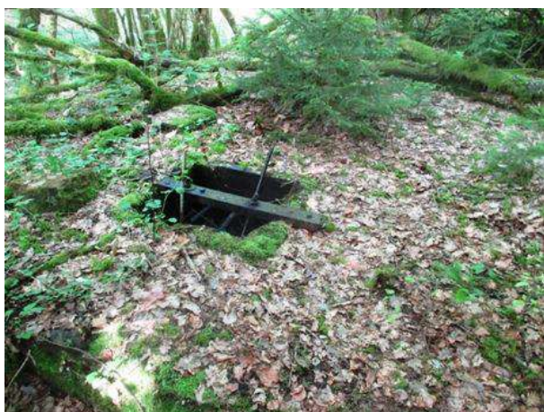
Cuve à fioul
