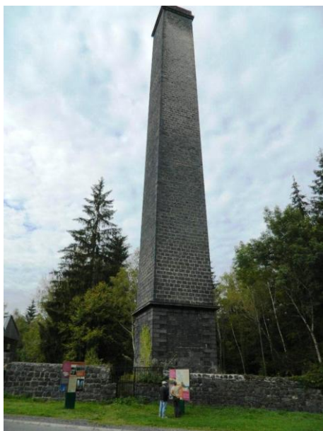
La cheminée de la fonderie
