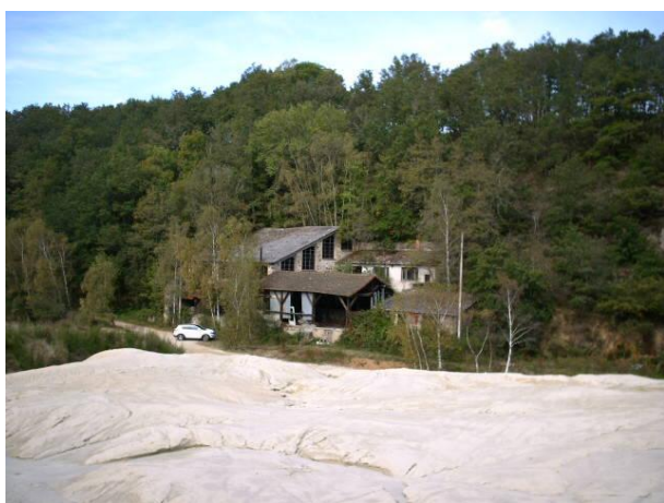
Vestiges de l'ancienne laverie
