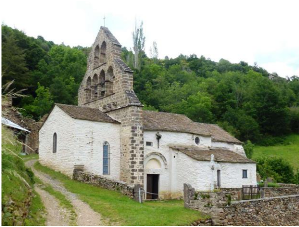
Eglise de Leyvaux
