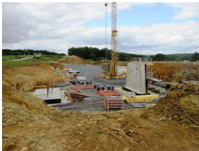
Le pont routier (3) en construction
